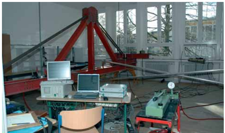
Abb. 8: Belastungsversuch in der Schule
