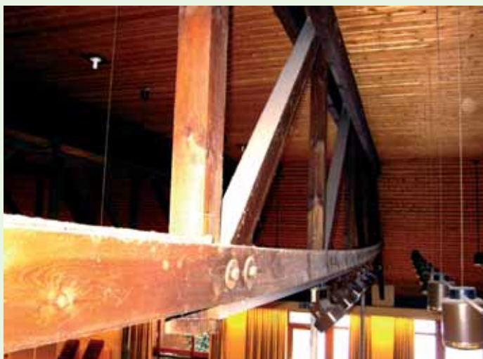
Abb. 13: Durchbiegung der Kanthölzer
