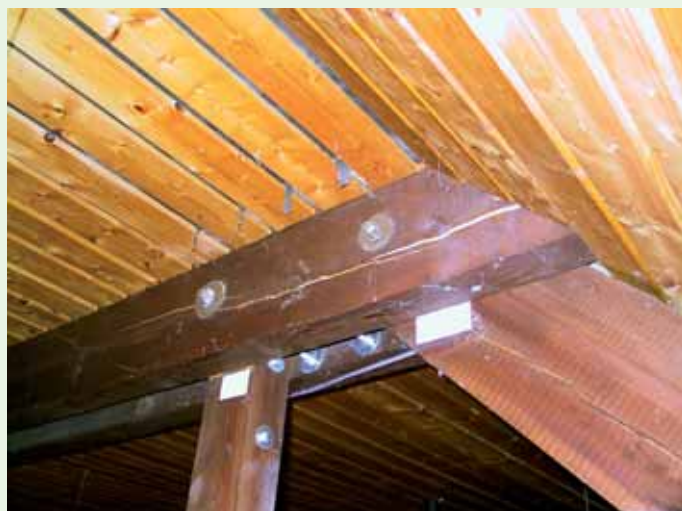
Abb. 14: Reparatur der Fachwerkknoten
