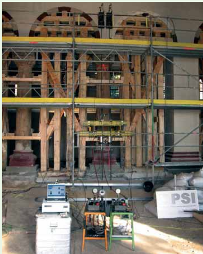
Abb. 20: Belastungsversuche in situ in der Michaeliskirche
