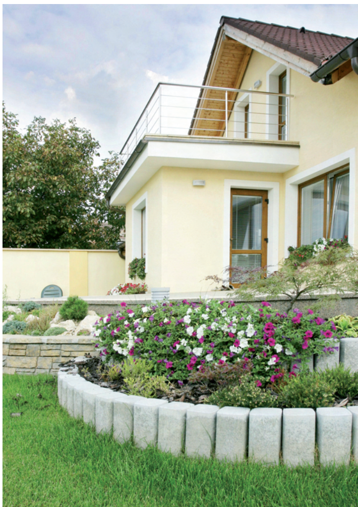
EINE VILLA musste teuer wieder bewohnbar gemacht werden, nachdem professioneller Leichtsinn erhebliche Schäden verursacht hatte.
