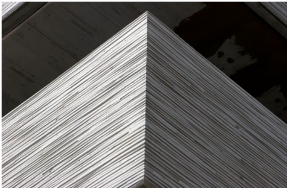
BAMBUSROHRE imitiert diese Sichtbetonfläche eines neuen Wohnhauses in Berlin. Die fein strukturierte Oberfläche ist das Abbild von Strukturmatrizen, die vom Rohbauer in die Betonschalung eingelegt worden sind (Architekt: Zanderroth Architekten, Berlin).
