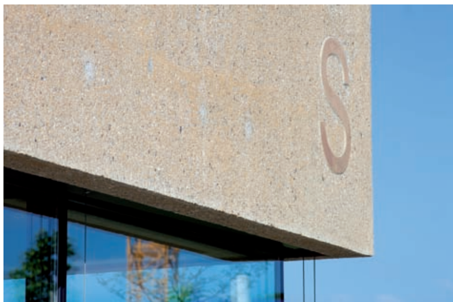
EINE ATTRAKTIVE BETONFLÄCHE ziert ein neues Bürgerhaus in der bayerischen Gemeinde Poing. Der Architekt Martin Bez realisierte dafür eine 32 Zentimeter starke tragende Betonschale, die ohne Fugen mit Ort beton in hoher Sichtbetonqualität hergestellt wurde.
